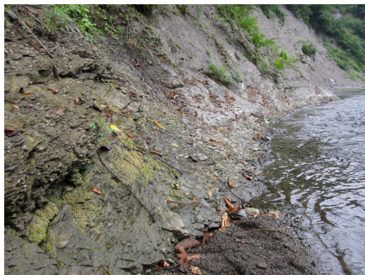
図3. 湧水の染み出している箇所.
