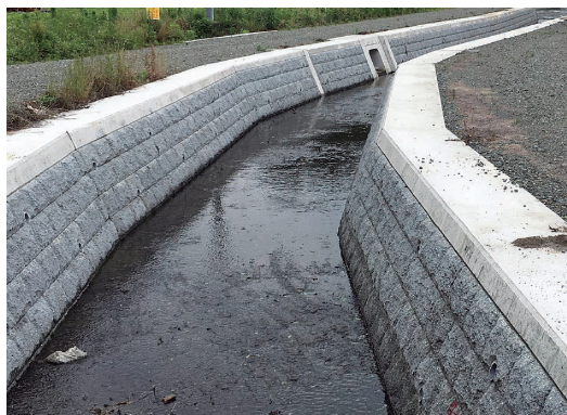
図3. 護岸化された水路。
